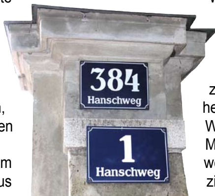
Die blauen Blechtafeln für Hausnummern und Straßentafeln wurden 1958 verordnet. Gelegentlich wurden auch noch Konskriptionsnummern in diesem Design angebracht, wie z.B. die heute noch am Faniteum ersichtliche. Das Faniteum hatte bis in die 50er Jahre ausschließlich die Adresse Hanschweg, CN (Konskriptionsnummer) 384.
